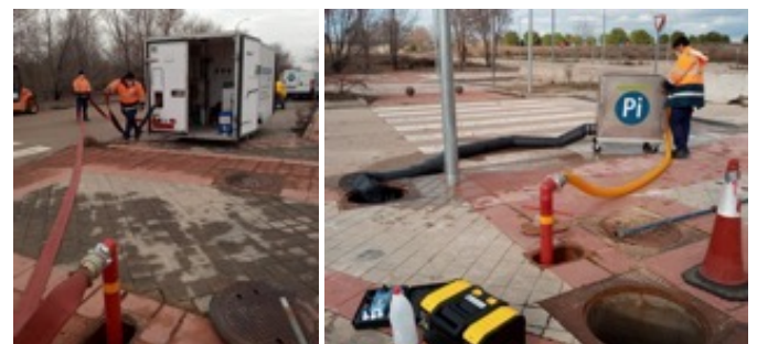
Instalación de inyección
